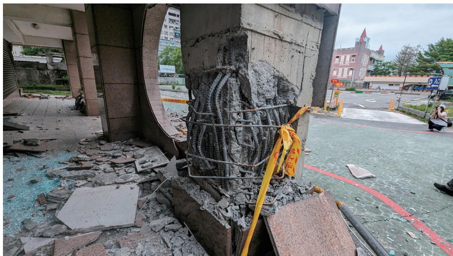
圖 12. 轉角柱損壞嚴重
