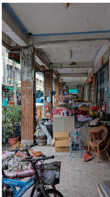
圖 14 騎樓柱頂混凝土剝落
