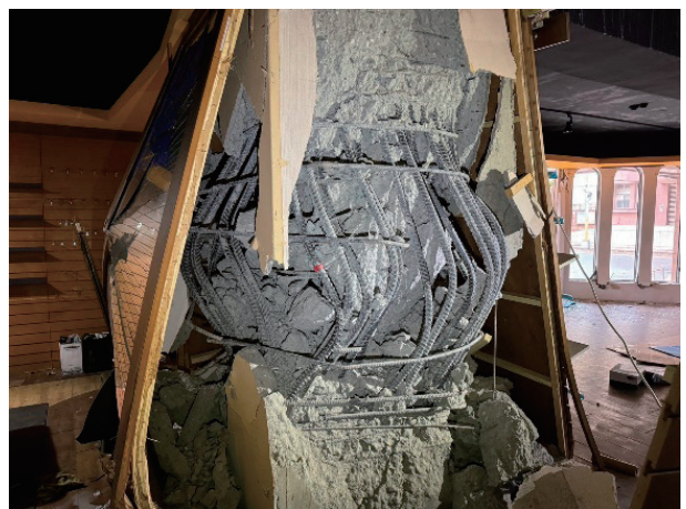
圖 11 柱爆裂主筋挫曲呈洋蔥狀
