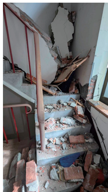
圖 16 頂樓 1/2B 磚牆傾倒
