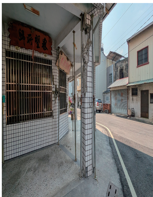
圖 15 轉角騎樓柱頂混凝土完全碎落
