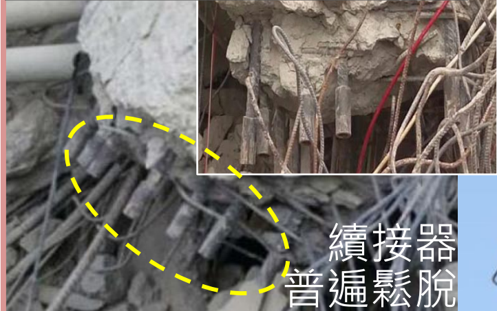
2016台南0206地震時的鋼筋續接器 - 嚴重鬆脫
