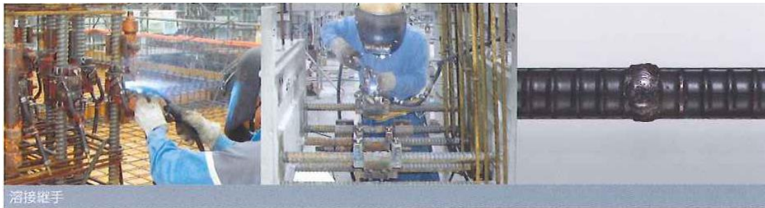
圖2.5 日本鋼筋接頭協會提供之鋼筋對銲現場施作圖(CB工法)
