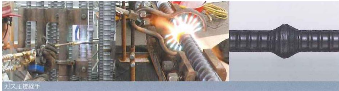
圖2.4 日本鋼筋接頭協會提供之瓦斯壓接現場施作圖
