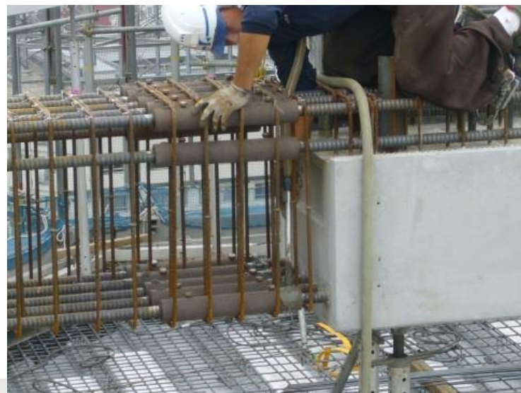
④砂漿注入充填
