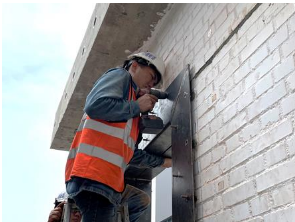
13.化學錨栓旋入孔內底部
