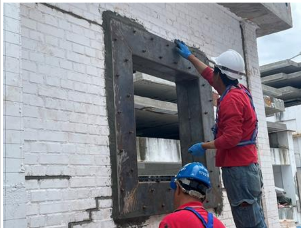
18.鋼板與磚牆牆面與開孔週邊空隙 填塞封填水泥
