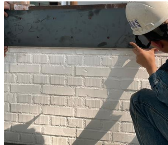
3. 標記預鑽孔位於磚牆牆面
