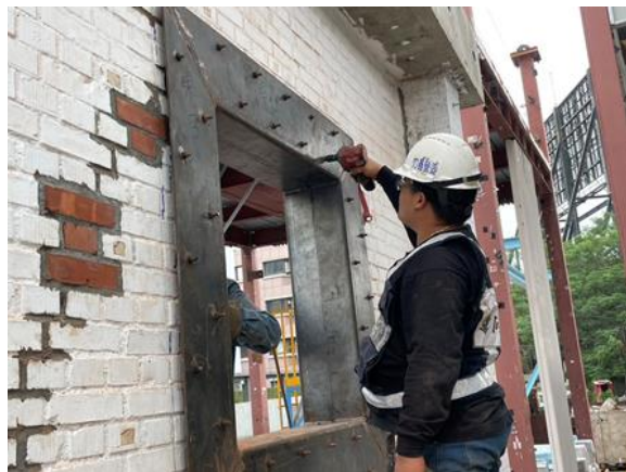
14.等待化學錨栓硬化後假固定
