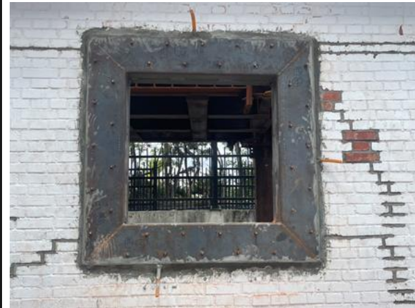
19.預埋無收縮水泥砂漿溢流、注入 管
