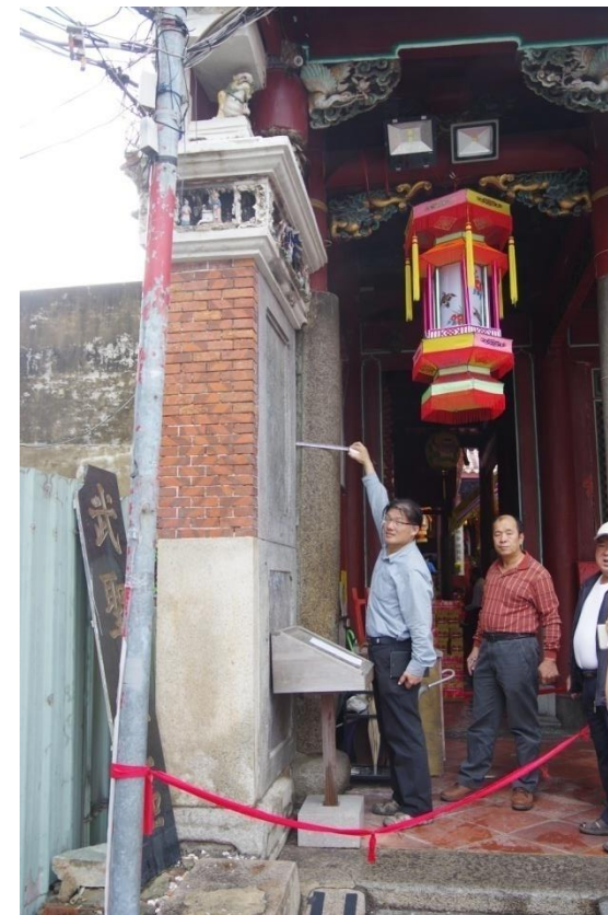
附壁柱與側牆脫離3.6cm
