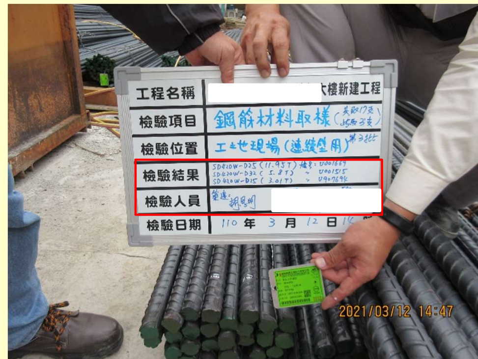
鋼筋取樣吊牌(爐號)確認
