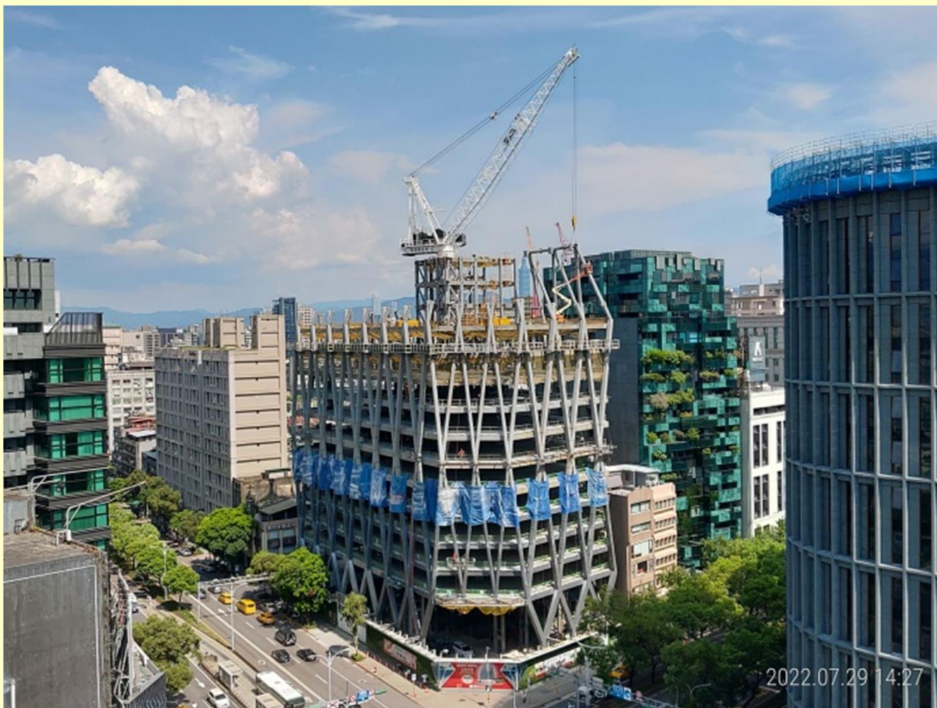
上海商業儲蓄銀行總行大樓第7節西側(A區)外圍造型鋼柱吊裝
