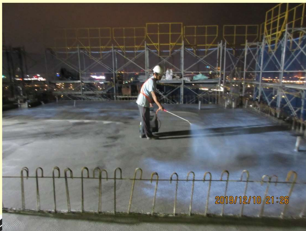
混凝土澆置後噴灑養護劑
