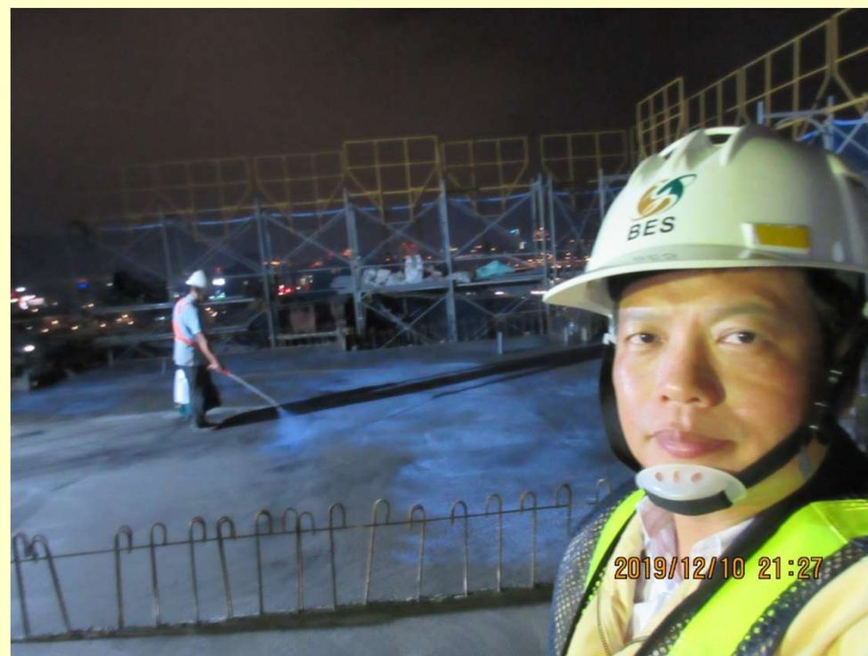
混凝土澆置後噴灑養護劑
