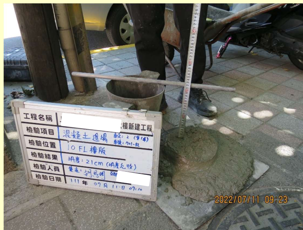
混凝土進場坍度確認(第1車管頭)
