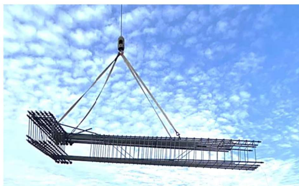
於工地以鋼筋籠單元品吊裝
