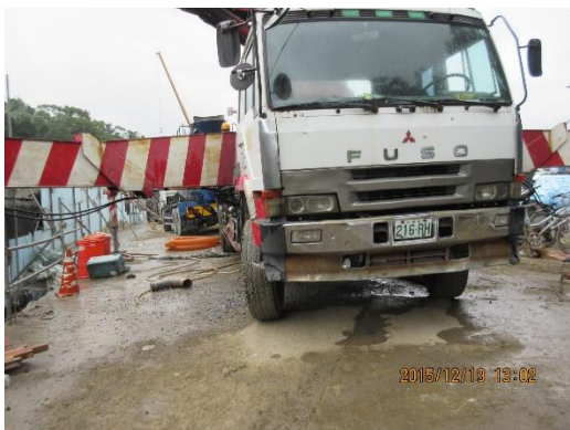
泵送車私接水管加水灌置
