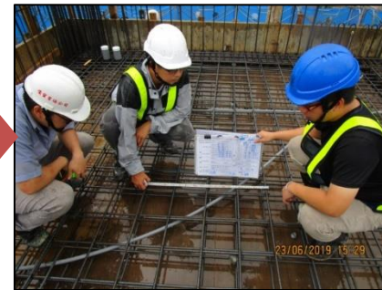
8. 版筋綁紮施工抽查驗
