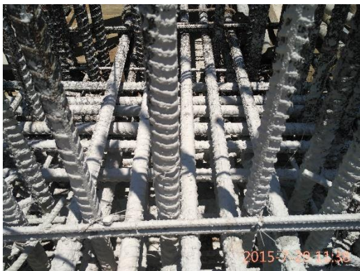
筏基地梁、柱主筋泥渣汙染未清除
