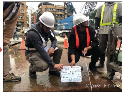
6. 壁體探掘深度檢測
