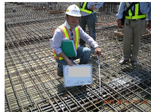
地梁箍筋過高直接90度彎折
