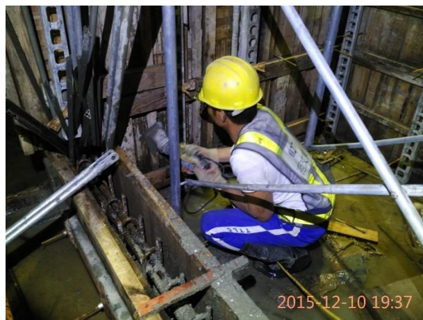
澆置時使用外模振動器
