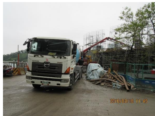
逾時90分鐘仍進行混凝土澆置
