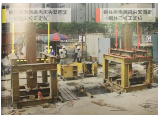
△ Step.5-1 逆打鋼柱定位連續性監督
