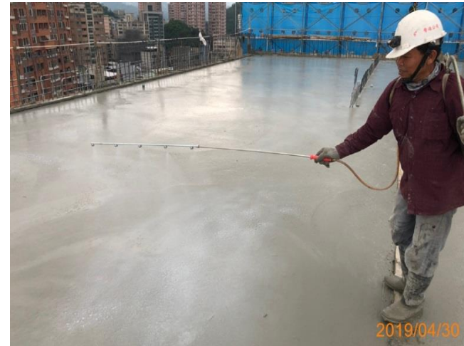
△ Step.9-2 混凝土養護作業(養護劑)
