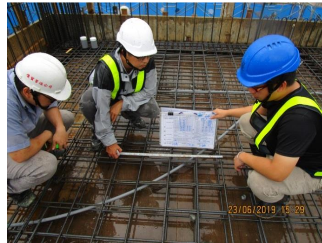
◎ Step.8 版筋綁紮施工抽查驗
