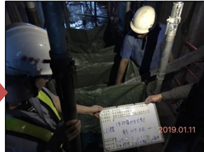
3.潤管砂漿澆置於結構體外
