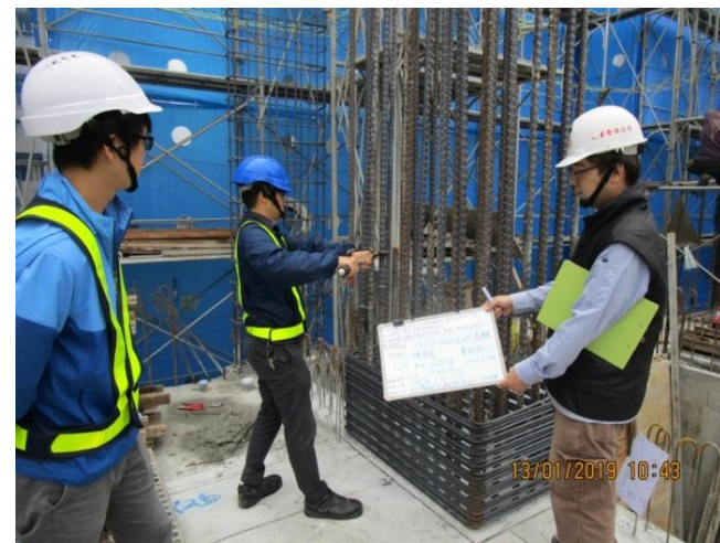
◎ Step.4 柱主筋續接器扭力測試
