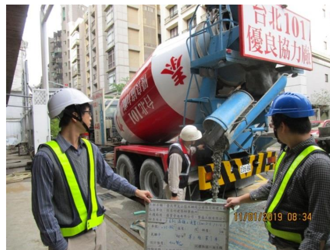
△ Step.4 混凝土進場取樣(管頭)
