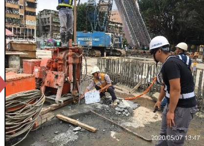
12. 樁底灌漿查驗(壁樁)
