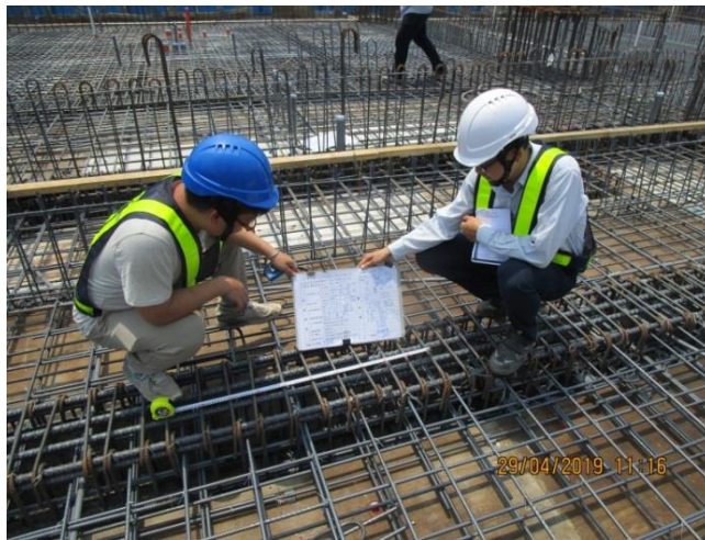
◎ Step.7 梁筋綁紮施工抽查驗
