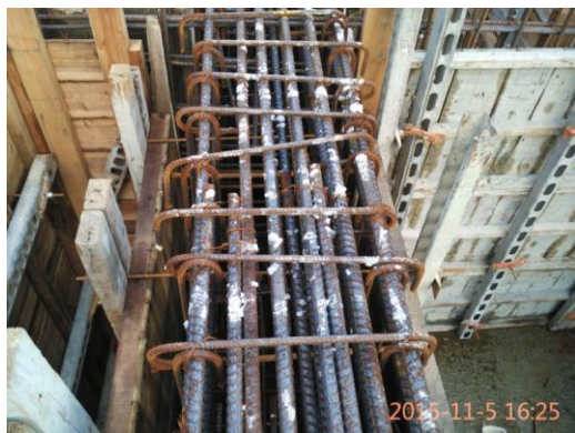
帽蓋箍未緊貼梁主筋(尺寸過大)
