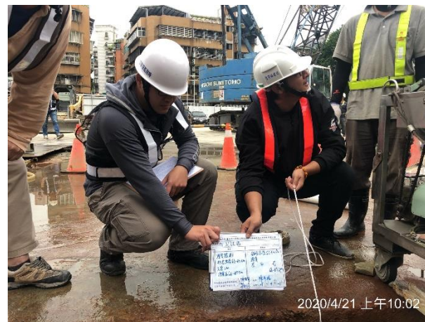
◎ Step.6 壁體探掘深度檢測
