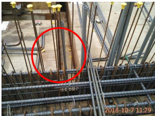
鋼筋保護蓋散落柱、梁、牆筋內
