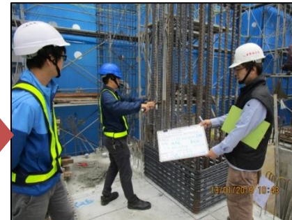
4. 柱主筋續接器扭力測試
