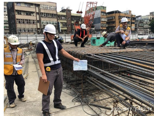
◎ Step.4 鋼筋籠(含預留筋)抽查驗
