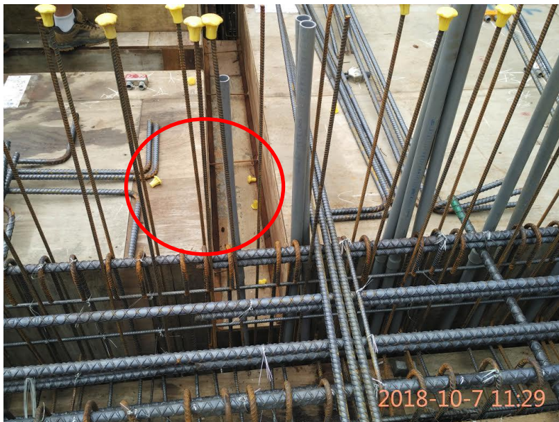
鋼筋保護蓋易散落柱、梁、牆筋內
