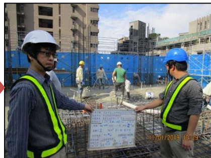
5.混凝土管尾取樣
