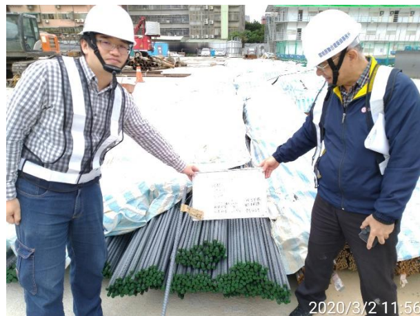
◎ Step.2 鋼筋現場取樣及標記
