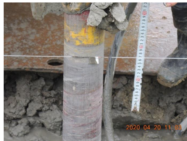
△ Step.4 鑽掘與噴射攪拌注灌作業 (鑽桿之迴轉速度、提升速度抽查)
