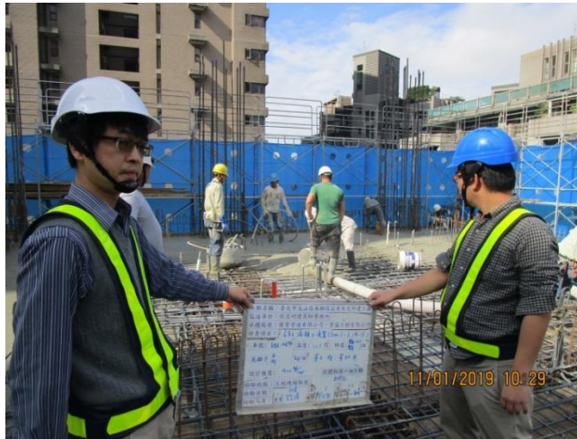
△ Step.5 混凝土管尾取樣
