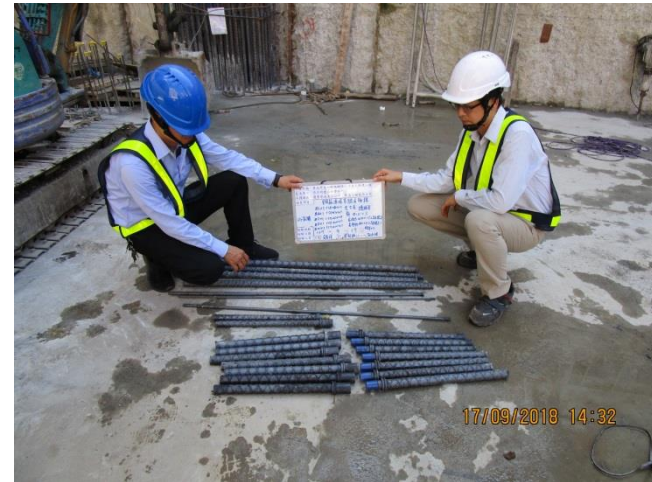
◎ Step.2 鋼筋現場取樣及標記
