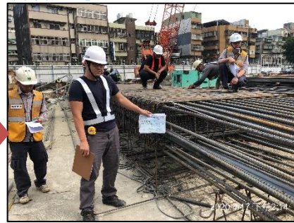
4. 鋼筋籠(含預留筋)抽查驗
