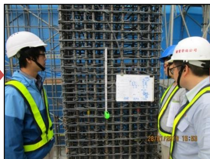
5. 柱筋綁紮施工抽查驗
