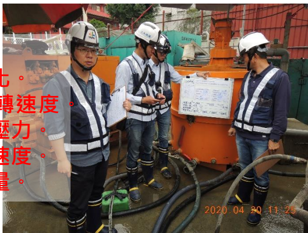
△ Step.3 鑽掘與噴射攪拌灌漿作業 (灌漿壓力、流量、拌合配比等抽查)
