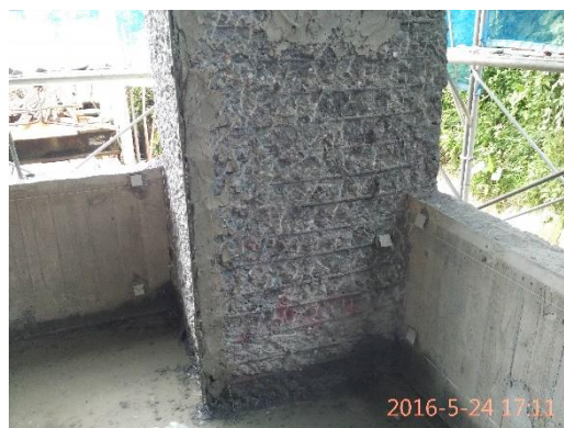
保護層不當敲除致柱箍繫筋外露
