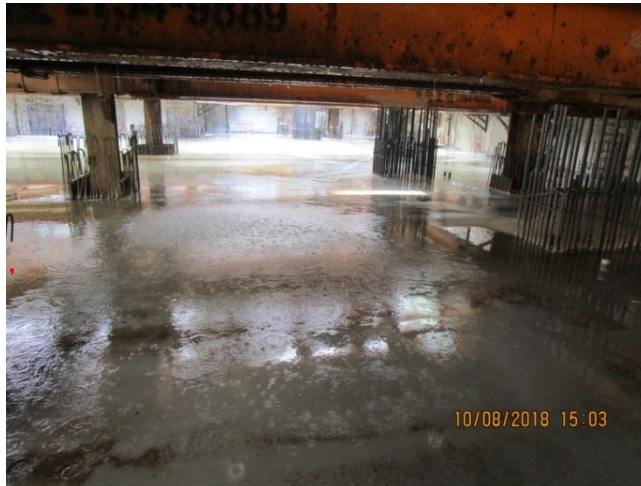
△ Step.9-1 混凝土養護作業(灑水)
