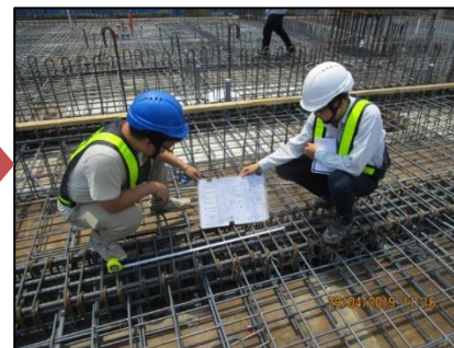
7. 梁筋綁紮施工抽查驗
