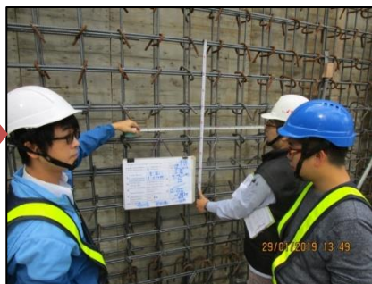
6. 牆筋綁紮施工抽查驗
