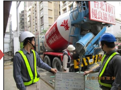
4.混凝土進場取樣(管頭)
