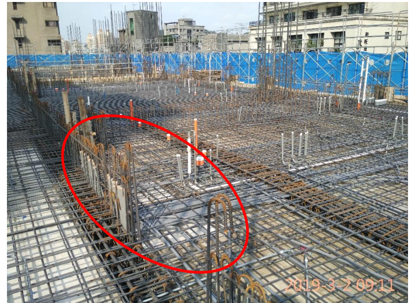
建議作法 牆筋改為180度彎鉤取代保護蓋
