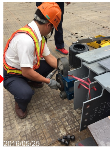
軸力計安裝及軸力(預拉力)施加
