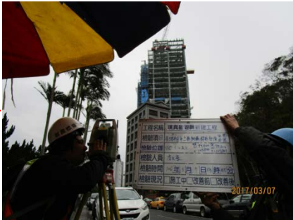
柱節對接處鉋位差 柱頂平面位置抽測 測量
