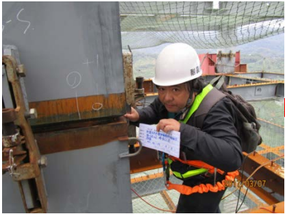
柱節對接處鉋位差 柱頂平面位置抽測 測量
