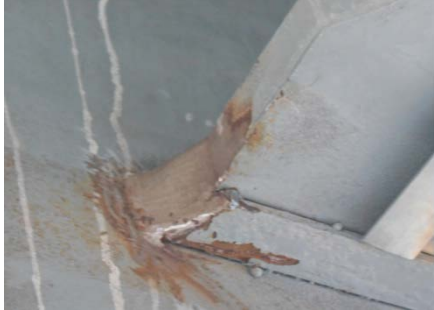
改善後 梁柱銲道端部處理再行處理至符合標準
