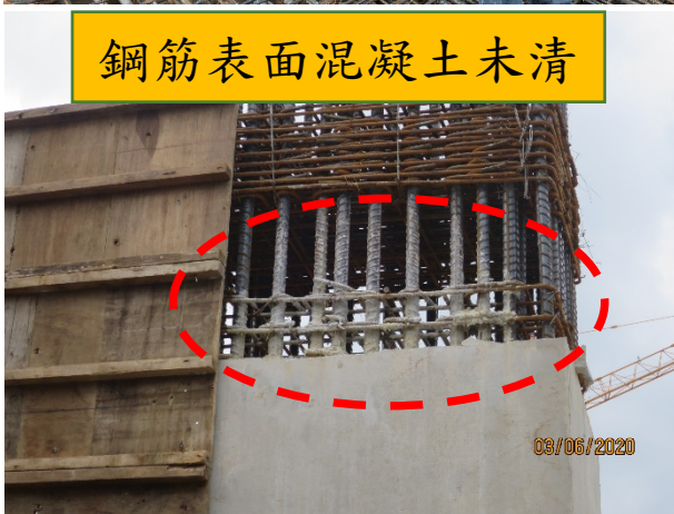
預留鋼筋保護層過大
