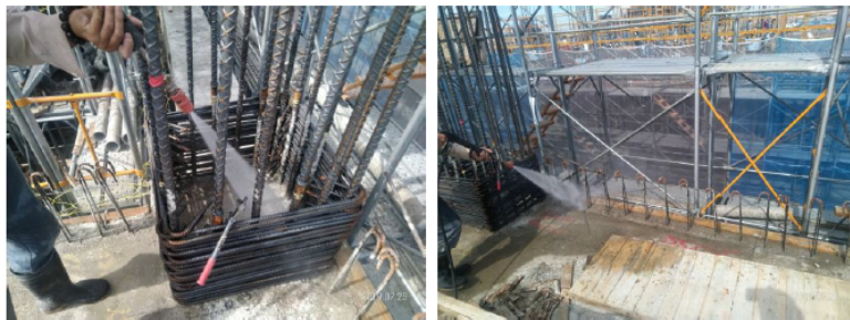
C 棟八樓版澆置過程中有下雨，事後昇層處以高壓水柱沖洗
