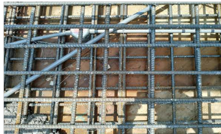
鋼筋未依規定逐步(跳步)綁紮
