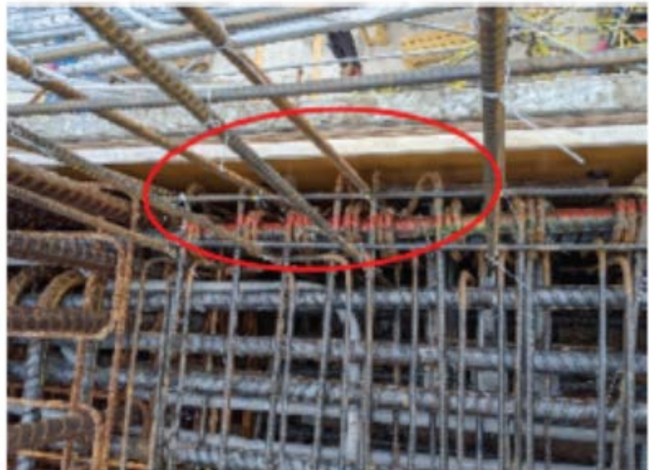
圖 1.2 梁與柱邊緣齊之梁主筋彎折後， 梁箍筋 135° 彎鉤端無法緊貼主筋。
